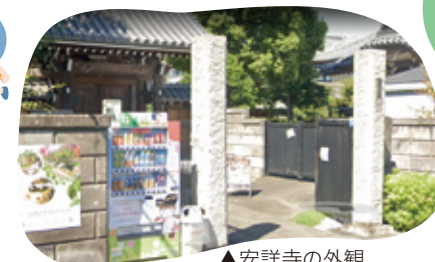
▲安詳寺の外観
